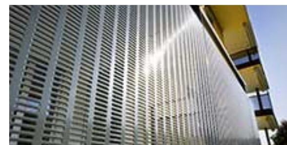
przykładowy sposób perforacji blachy
